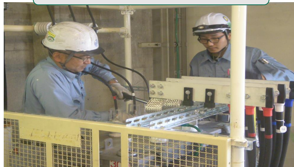
高圧受電機器内ケーブル接続工事
