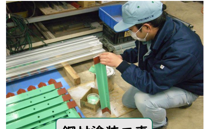
鋼材塗装工事
