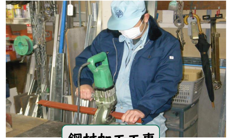
鋼材加工工事
