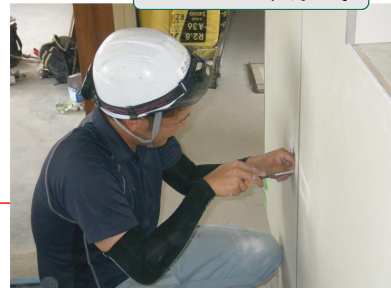
コンセント取付工事
